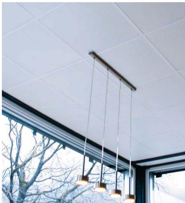
▲ Deckenabsorber aus SonoPerf, monochrom beschichtet
