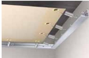
Système de fixation par laçage ou ressort.
